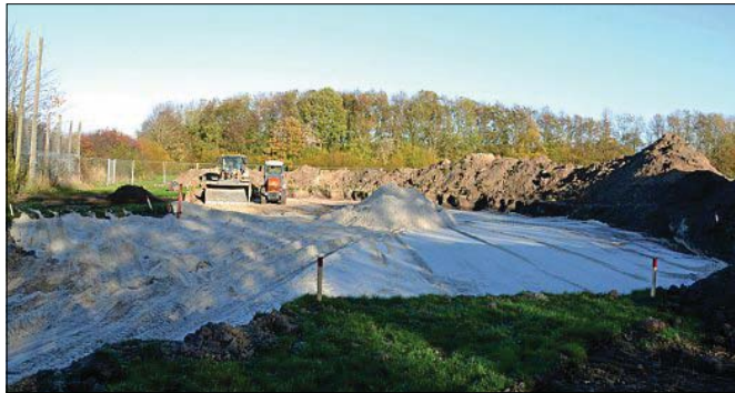
Hohe Erdwälle werden als Vorbereitung für Skateelemente aufgeschichtet und der Boden wurde ausgekoffert und durch Füllsand ersetzt. FOTO: RUHR
