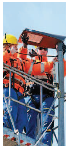
Alte Lampen wurden durch neue LED-Scheinwerfer ersetzt.
