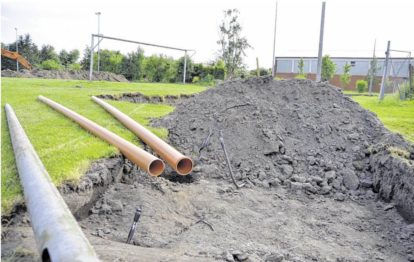
Die Arbeiten auf dem alten Sportplatz an der Rechtsupweger Grundschule haben begonnen.
