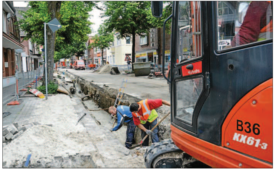
Die Arbeiten liegen im Zeitplan. In etwa sechs Wochen können Autofahrer wieder durch die Westerstraße fahren. FOTO: RUHR
