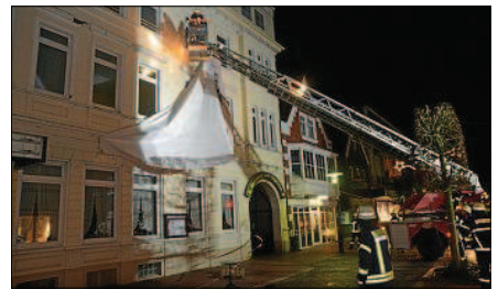
Im Neuen Weg drohte ein Werbeplakat samt Mauerwerk abzustürzen.
