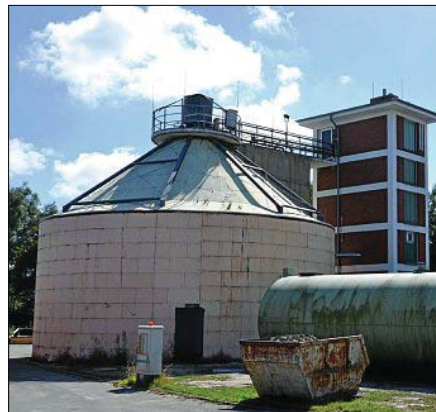
Der Faulturm am Norder Klärwerk wurde 1962 in Betrieb genommen. Ein Neubau ist laut Experten erforderlich.
