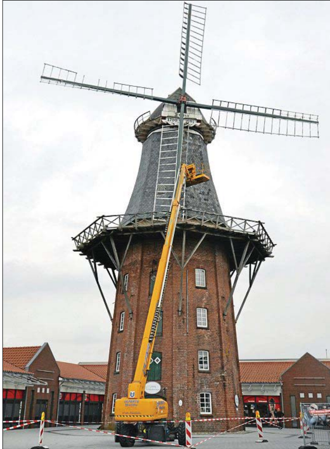
Schon gestern wurde mit schwerem Gerät an der Mühle gearbeitet. Aus Sicherheitsgründen ist die Demontage der maroden Holzelemente an der Frisia-Mühle notwendig. FOTO: RUHR
