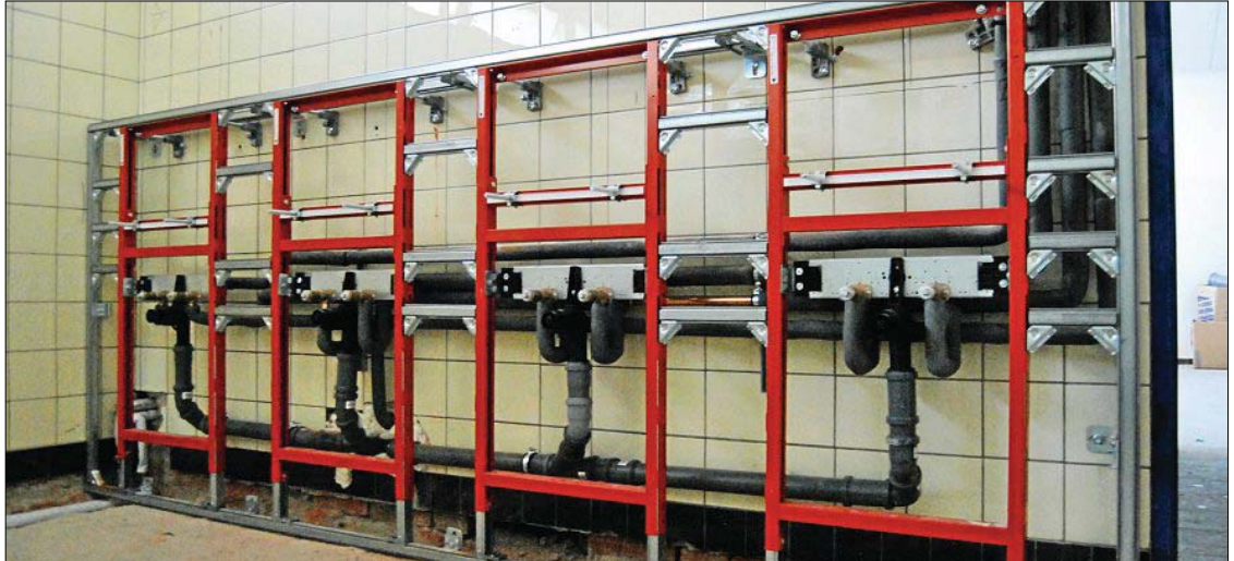
Die Vorwandinstallation für die Waschbecken im Duschaum der Jungen-Umkleidekabine ist schon eingebaut worden.
