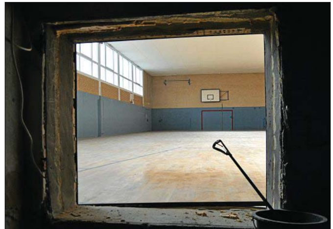
Der Lüftungsschacht der alten Heizung muss noch geschlossen werden. Durch ihn ist die Turnhalle zu sehen. Dort soll der Boden herausgerissen und ersetzt werden.
